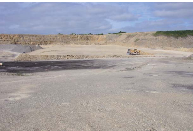
Abbildung 1: Tagebaurestloch (Kalksteintagebau), Herrichtung der Aufstandsfläche für eine Deponie DK I
