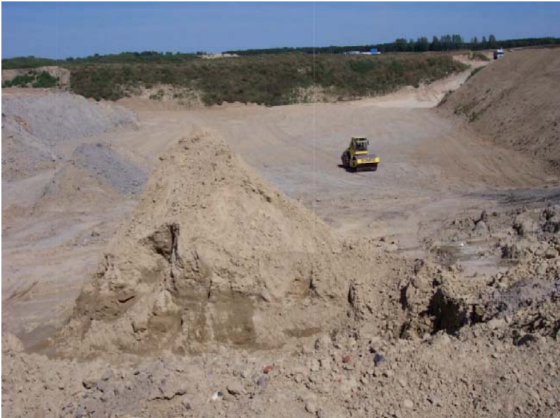
Abbildung 2: Tagesbaurestloch (Kies-/Sandabgrabung), Herrichtung der Aufstandsfläche für eine Deponie DK I
