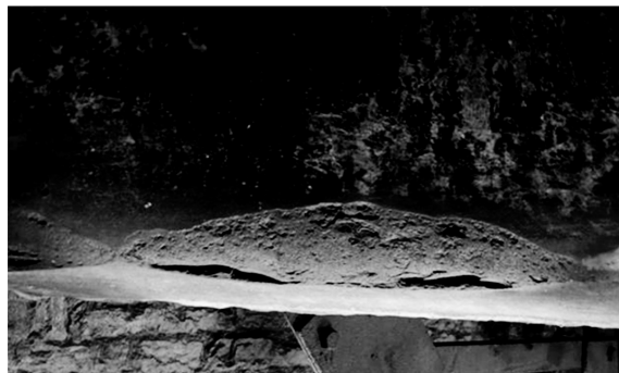
Abb. 2: Schlagverschleiß am Anschlag
