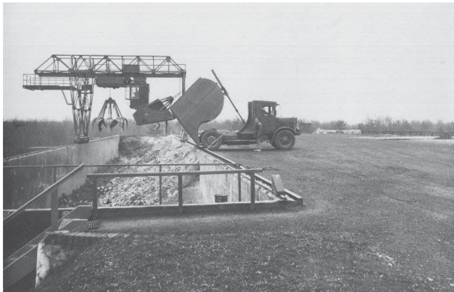
Abbildung 1 Der Müllumschlag im Altwarmbüchener Moor (Archivaufnahme aha)
