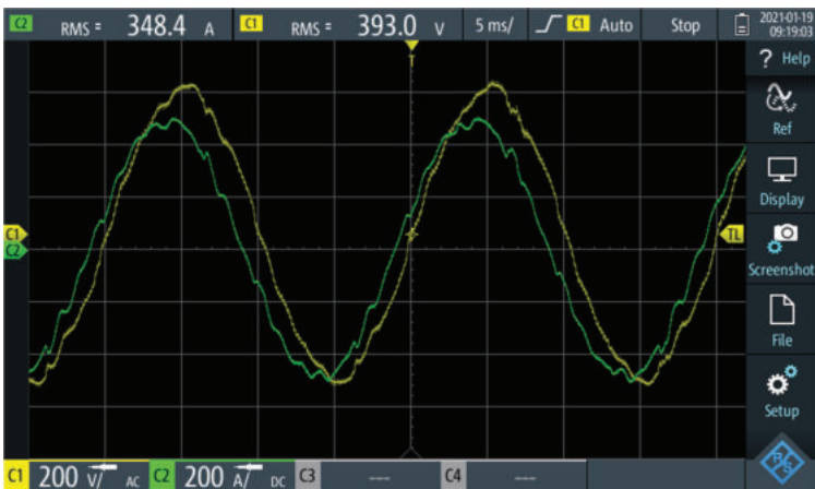
Abbildung 7-32: Stationärer Ladebetrieb der Batterie mit 350 A AC
