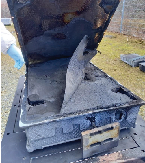
Abbildung 5-42: Öffnung des Havarie-Racks – BV ohne BS
