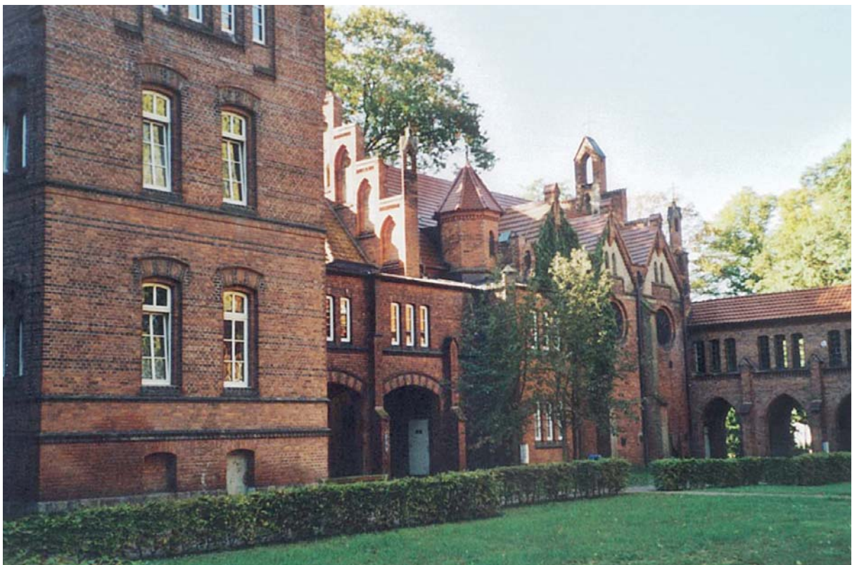
Abb. 24: Die Bolbrüggesche Mühle, Innenanlage
