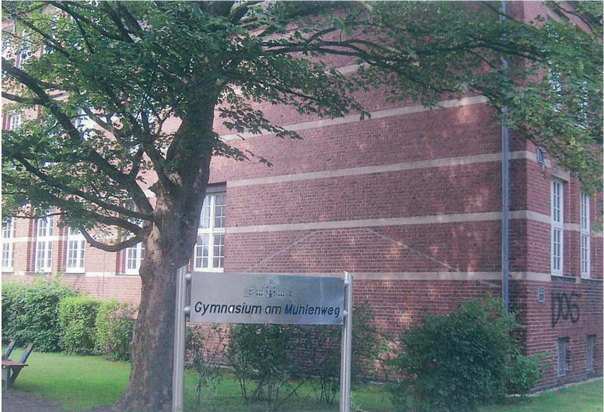
Abb. 34: Jürgen und Peters erstes Gymnasium am Mühlenweg in Wilhelmshaven
