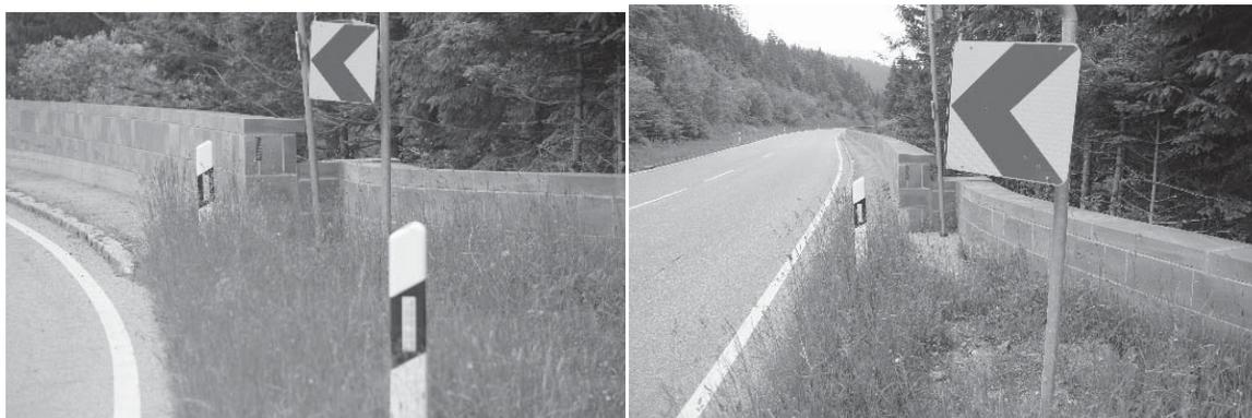
**Abbildung 14: Offene Strukturen am Kurveneingang einer Motorradstrecke**
