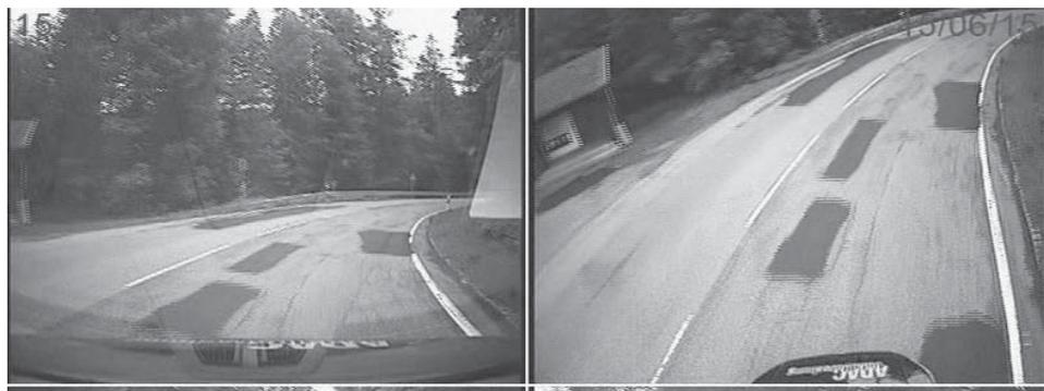
**Abbildung 17: Schadstellen/Reparaturstellen im Fahrbereich von Motorrädern**
