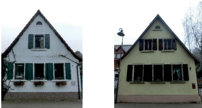
Haus Jones/ehemals Haus Feig und Haus Estermann/Haus Habermehl Manfr.
