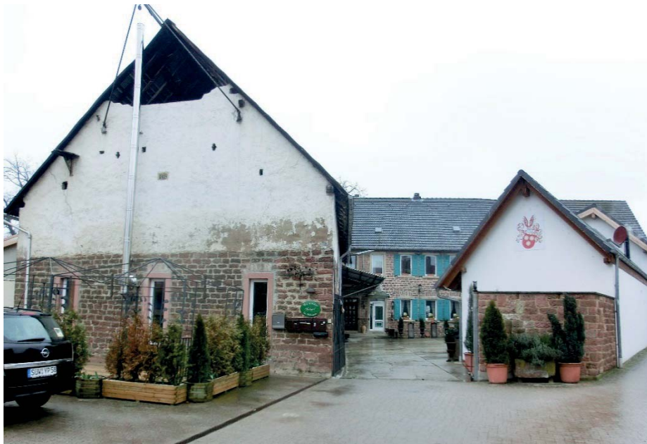
Ansicht der Mühle von Osten kommend
