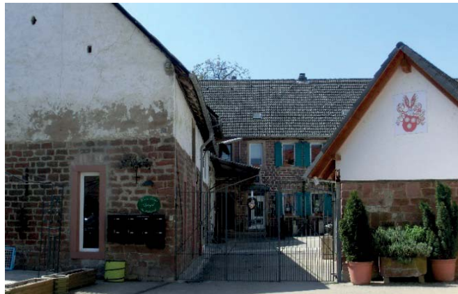
Rechts: Ansicht der Mühle von Osten mit Eingang zum umbauten Innenhof.
