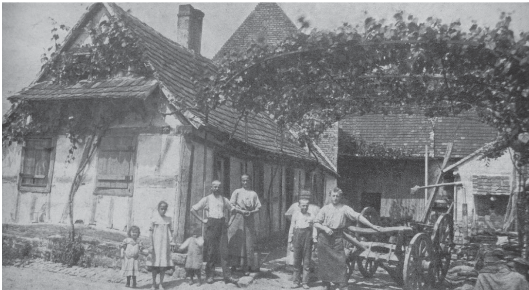
Ein Haus am Ortseingang von Großfischlingen um 1930
