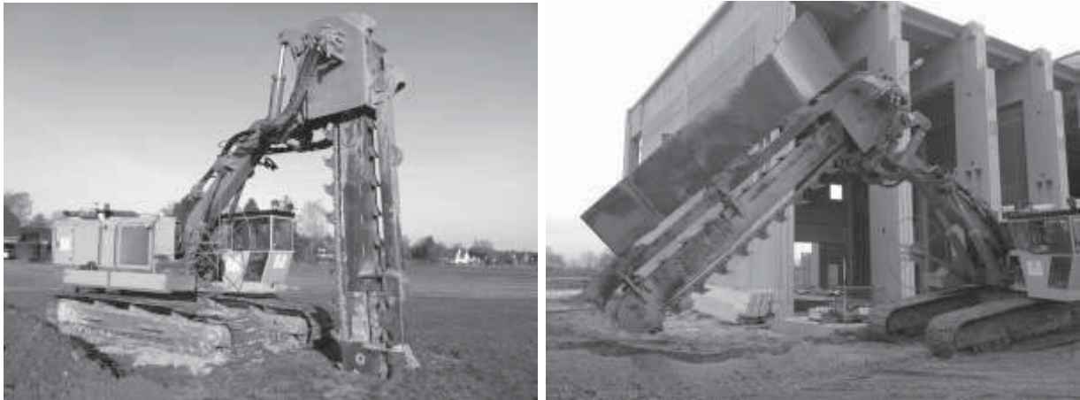
Abbildung 4: Tiefenfräse ohne und mit Verbauschlitten (Quelle: Christoffers Kulturbau GmbH)
