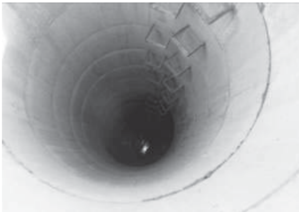
Abbildung 23: Vorschacht D10a vor der Sanierung mittels GFK-Inliner
