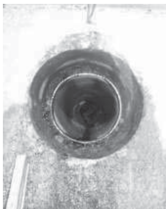
Abbildung 29: Eingerammtes Stahlrohr
