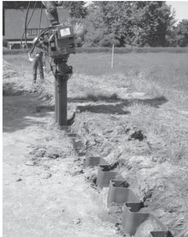
Abbildung 8: partieller Bodenaustausch mit Kunststoffspundwand (Quelle EWE Netz GmbH)
