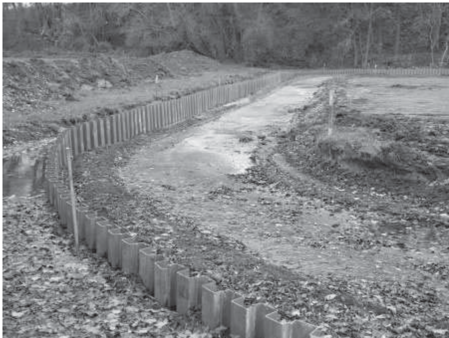
Abbildung 6: fertiggestellte Kunststoffspundwand
