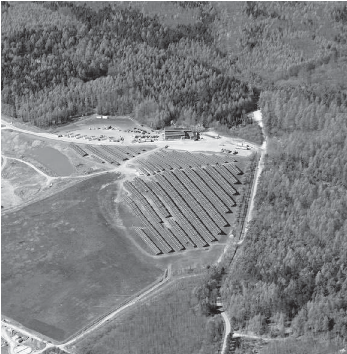
Abbildung 1 Deponie Hofgeismar [U9]
