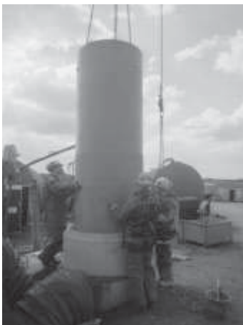
Abbildung 31: Setzen des GFK-Inliners
