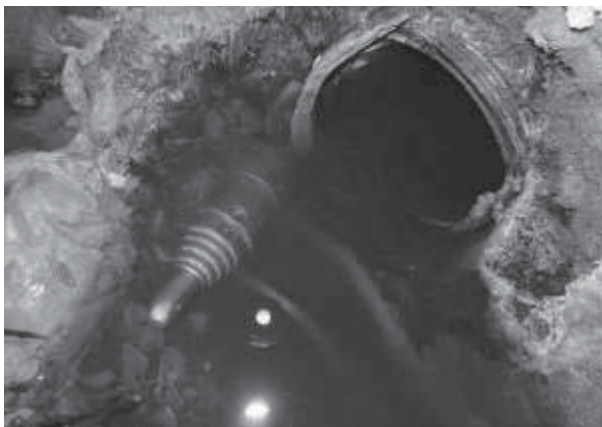
Abbildung 27: Ankunft der Pilotbohrung im Zielschacht D10a
