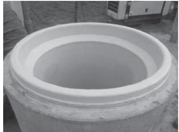
Abbildung 34: Anschluss an Betonschacht
