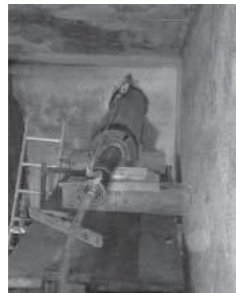
Abbildung 28: Installation und Ausrichtung der Erdrakete im Sickerwassertank
