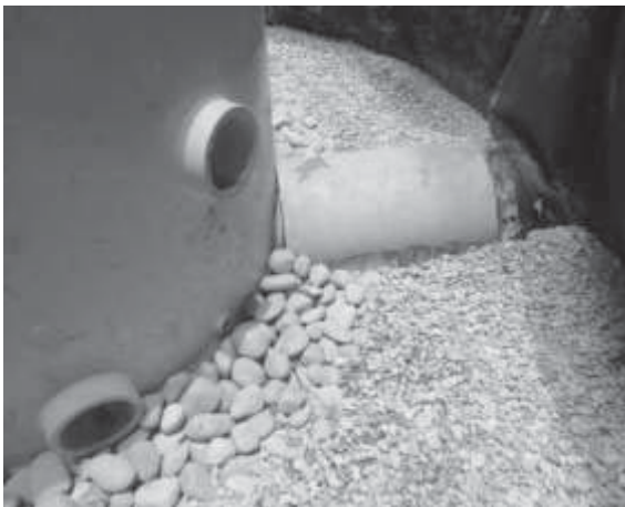
Abbildung 10: Abgestufter Drainagekies um Schachtunterteil mit eingebautem Hüllrohr
