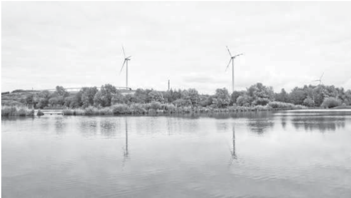
Abbildung 4 Blick auf die Windkraftanlage von Süden (Bild SRH Hamburg)
