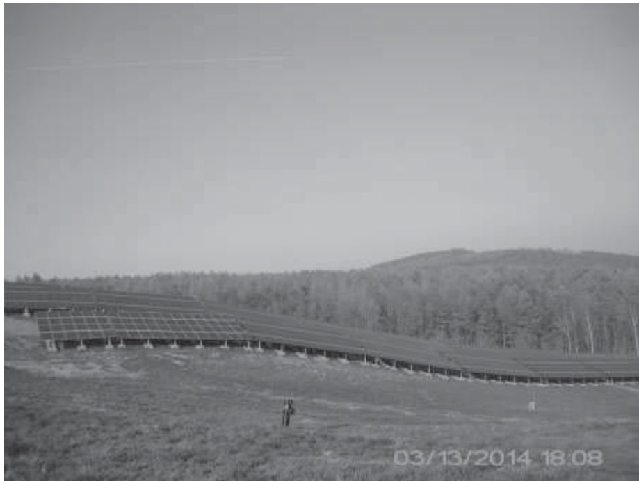
Abbildung 5 Beispiel für Gründung mit gebrauchten Bahnschwellen
