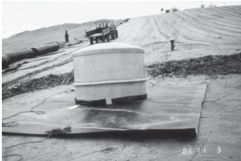
Abbildung 3 Gasschacht während der Sanierung (Bild BSU Hamburg)
