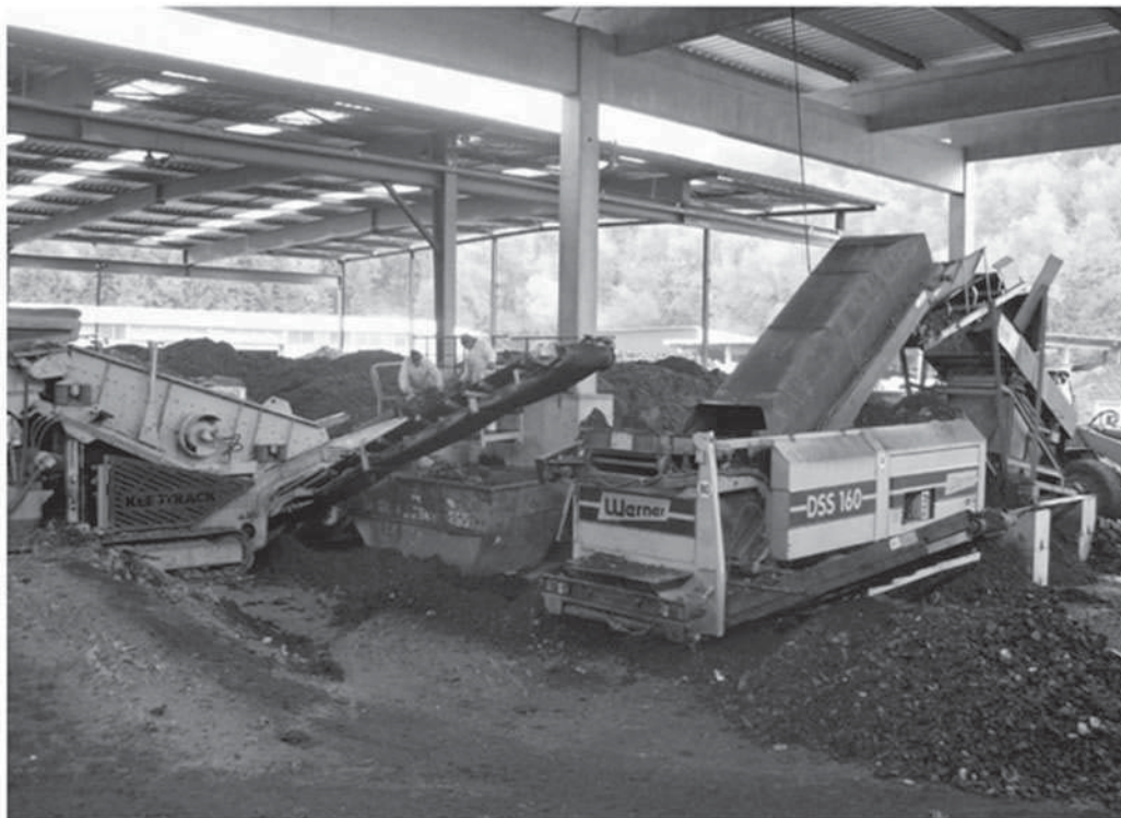
Abbildung 3: Trennverfahren auf dem Gelände der AKR. V.l.n.r. Schwerlastsieveanlage mit manueller Nachsortierung, Schwerefaller und Spannwellensieb (HÖLZLE 2010)
