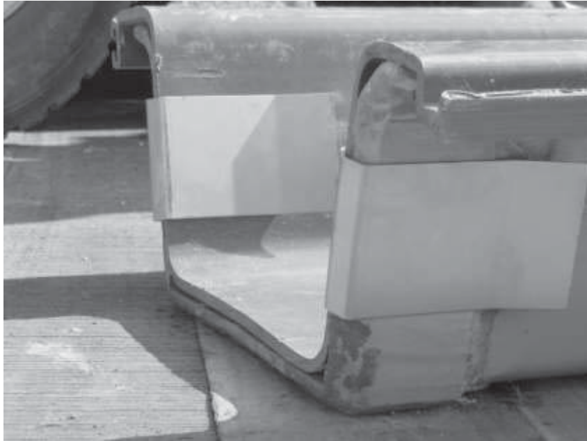
Abbildung 3: Mitlaufende Mutterbohle und Stahlklammern
