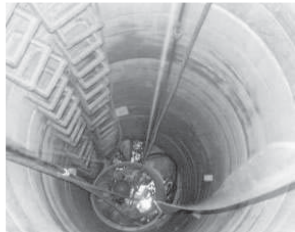
Abbildung 18: Einwickeln des Profilstreifens im 17 m tiefen Vorschacht D10a
