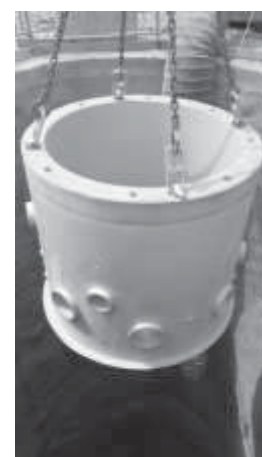
Abbildung 9: Setzen des fertigen Schachtunterteils
