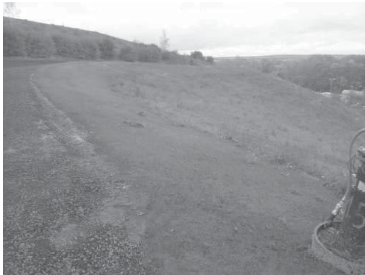
Abbildung 14 Rekultivierung von Kabelgräben nach Abschluss der PV Installation
