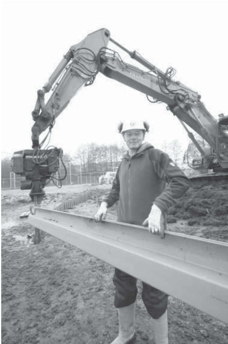
Abbildung 1: Einfache Handhabung der Kunststoffbohlen auf der Baustelle
