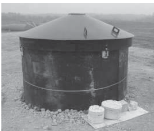
Abbildung 15: Erneuerter Sickerwasser-Drainageschacht mit Betonprobekörpern
