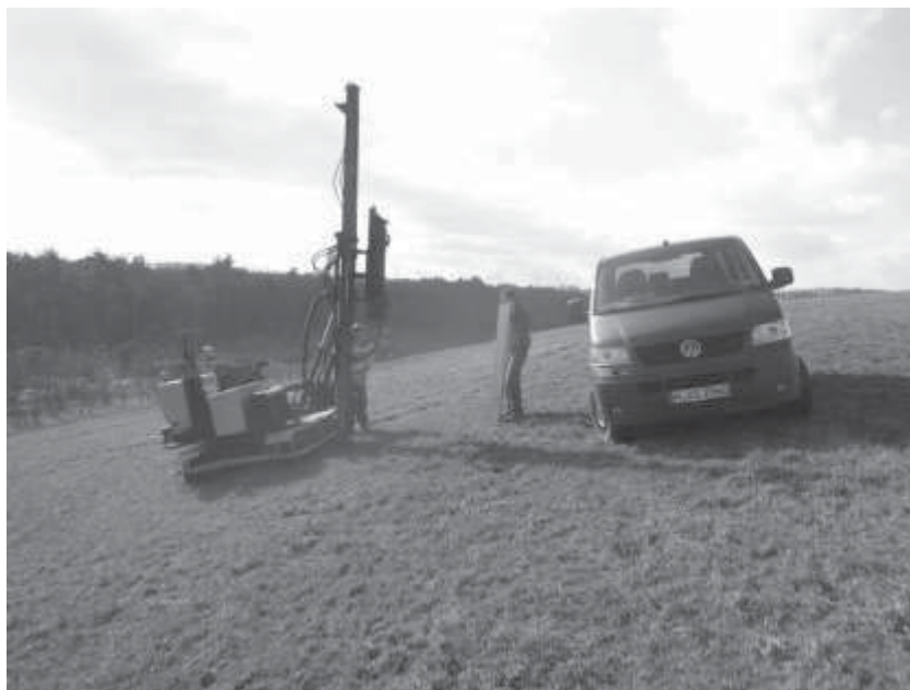
Abbildung 20 Vorbereitung einer Klein-Rammpfahl-Gründung an einem 15° geneigten Hang
