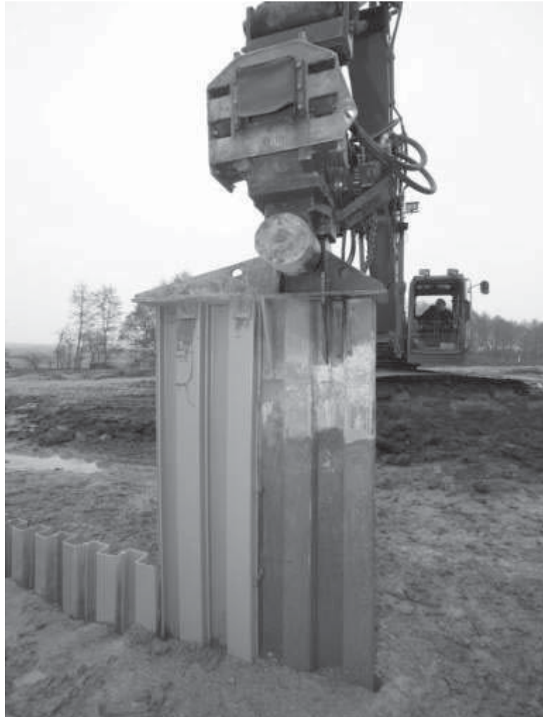
Abbildung 2: Kunststoffbohle mit vorlaufender Mutterbohle
