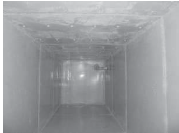
Abbildung 36: ...nach der PE-Auskleidung
