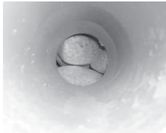
Abbildung 11: Blick aus einer Drainageöffnung auf den Drainagekies 50/150
