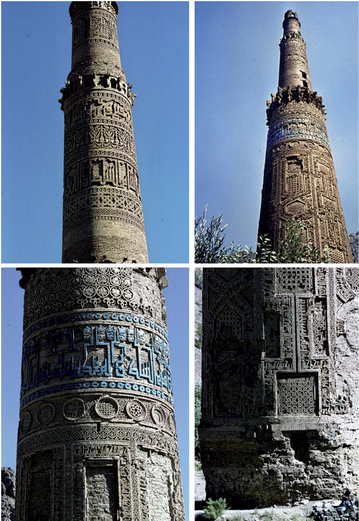
Abbildung 21: Das Minarett von Jam. Vier Ansichten. Foto 1978: Jo. Brechna.
