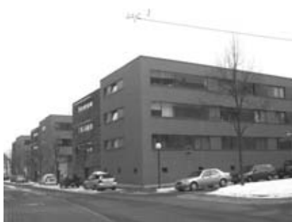
Abbildung 45: Wohnanlage in Ludwigsburg, Nordwestansicht Eigene Aufnahme
