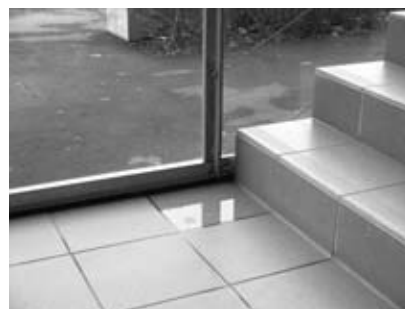
Abbildung 52: Wohnhäuser in Heumaden, Noppenfolie als Dämmung im Wintergarten Abbildung 53: Wohnhäuser in Heumaden, stehendes Wasser in Erschließungszone Eigene Aufnahmen
