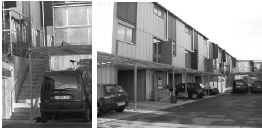
Abbildung 25: Reihenhäuser in Tübingen, Außentreppe
