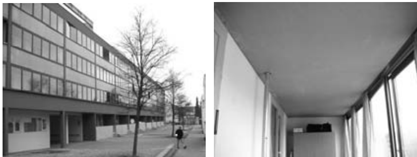
Abbildung 62: Wohnanlage in Neu-Ulm, Südansicht der Etagenwohnungen Abbildung 63: Wohnanlage in Neu-Ulm, Innenansicht Decke Wintergarten Eigene Aufnahmen
