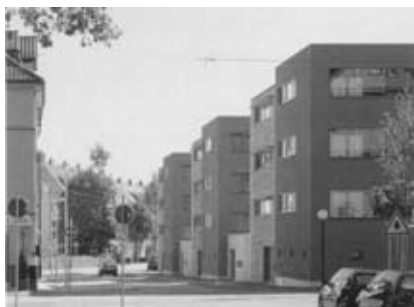
Abbildung 14: Wohnanlage in Ludwigsburg, Straßenansicht Quelle: Schittich 2004,164
