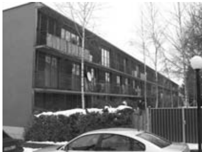
Abbildung 44: Wohnanlage in Ludwigsburg, Südbalkone Eigene Aufnahme
