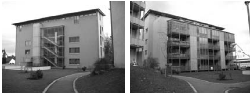
Abbildung 15: Wohnhäuser in Heumaden, Nordansicht
