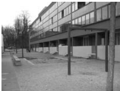
Abbildung 65: Wohnanlage in Neu-Ulm, Spielbereich in der Anlage Eigene Aufnahme
