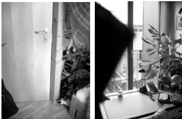
Abbildung 23: Reihenhäuser in Tübingen, Stütze im Kinderzimmer Abbildung 24: Reihenhäuser in Tübingen, eingeschränkte Möblierungsmöglichkeit Eigene Aufnahmen
