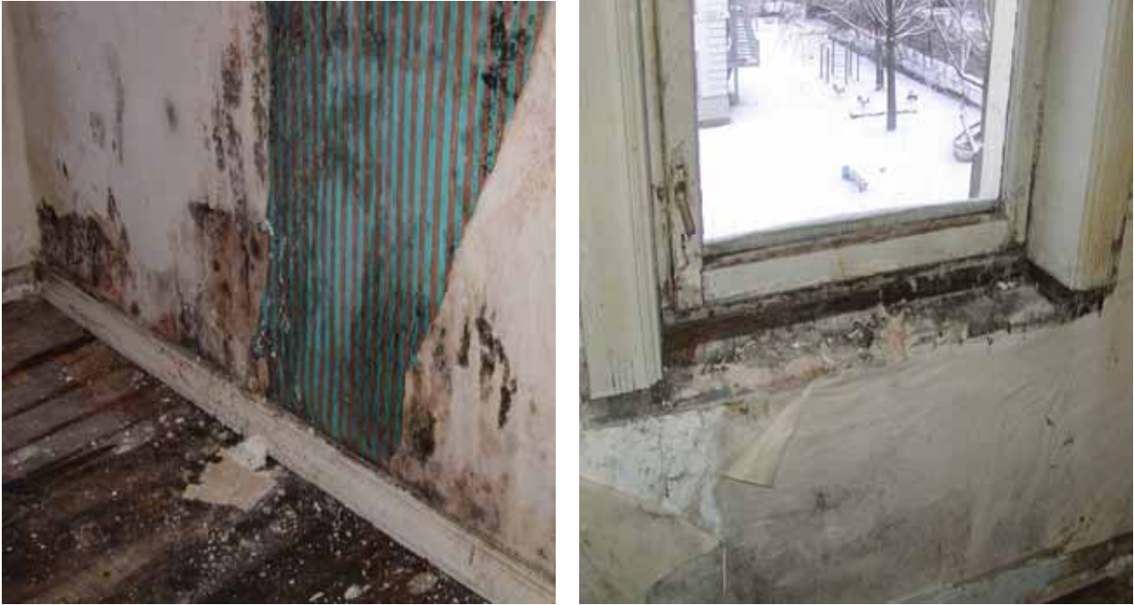
Abbildung 31: Schimmelpilzbefall
