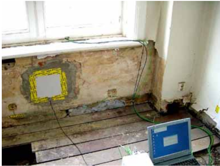
Abbildung 43: Wärmestrommessung an der straßenseitigen Außenwand
