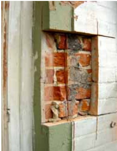
Abbildung 35: Materialprobenentnahme straßenseitige Außenwand
