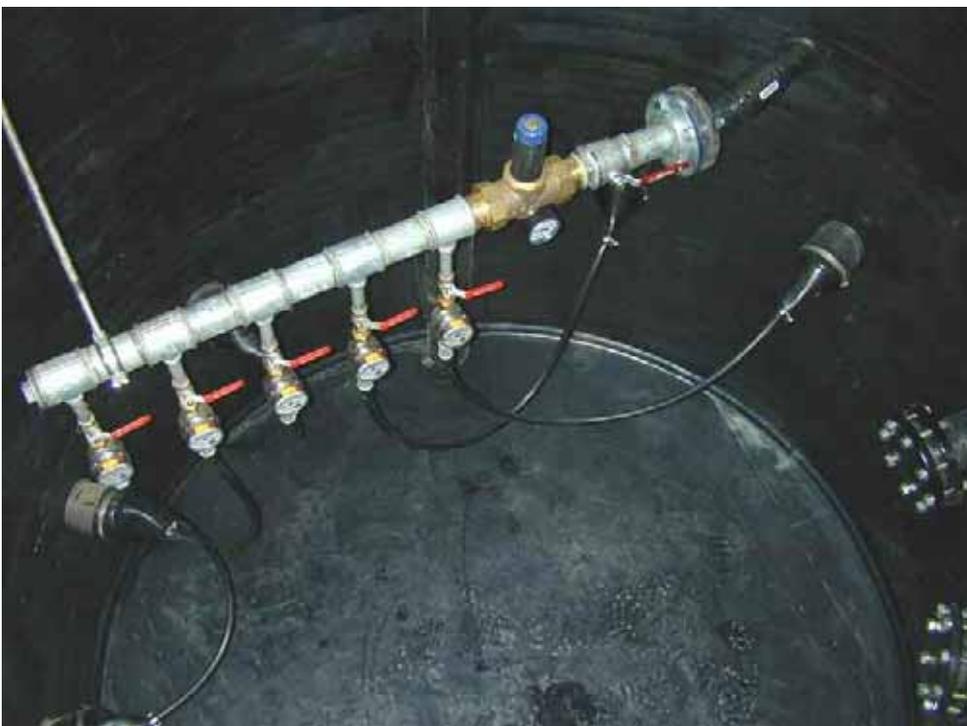
**Abbildung 6** Bewässerungsschacht mit Wasserverteilsbalken, Kugelhähnen, Wasseruhren und Druckminderern
