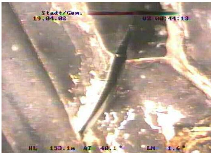
**Abbildung 4** An einem Drainageschlitz beginnende Rissbildung
