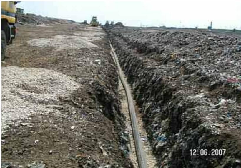
**Bild 3** Ausführungsbeispiel einer Entgasungsrigole
