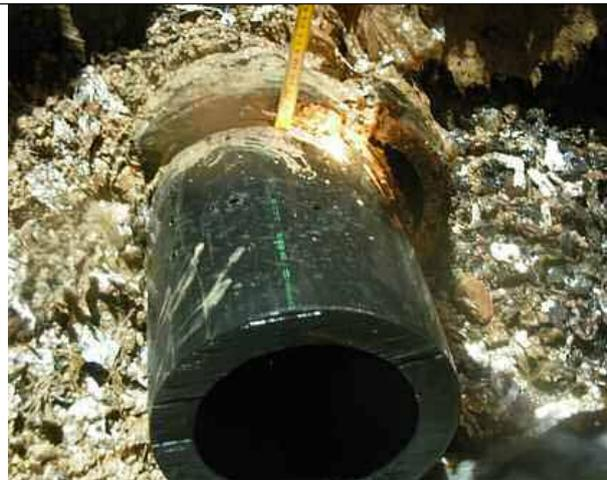
**Abbildung 7:** Eingezogenes Sanierungsrohr
