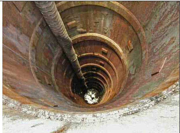
**Abbildung 5:** Schacht mit Stahlrohrverbau
