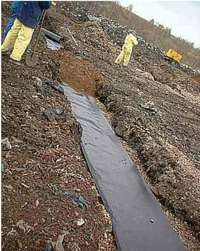
**Abbildung 6** Infiltrationsrigole während der Bauphase
