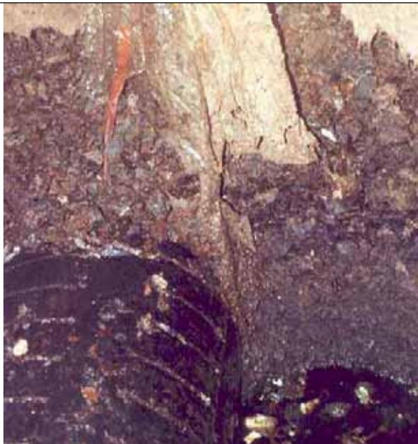
**Abbildung 6:** Kiesüberdeckung des freigelegten Altrohrs
