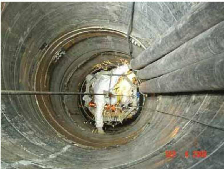
**Abbildung 1: Sanierung eines eingedrückten PEHD-Schachtes mittels Stahlhülsen**
