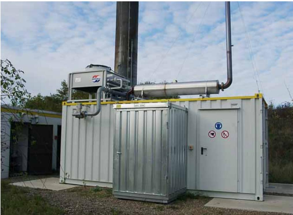
Abbildung 3: Deponiegas-BHKW mit Gasverdichter (Kompaktanlage 143 kWel)
