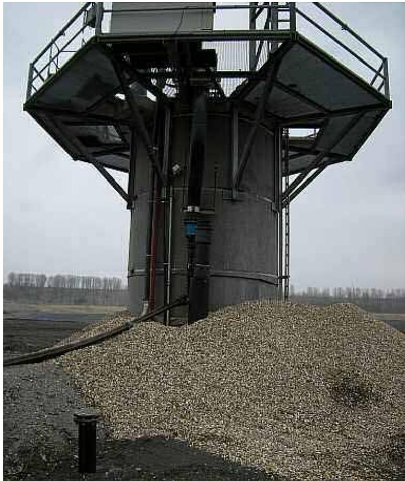
**Abbildung 1** Pumpenschacht S5 zur Sickerwasserfassung
