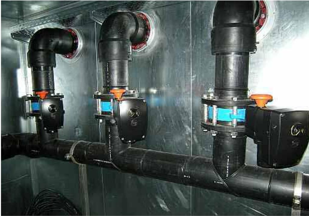
**Abbildung 2** Gesteuert betriebener Verteilerbalken
