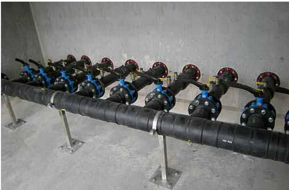
**Abbildung 7** Im Modul angeordnetes zusätzliches Verteilerbauwerk
