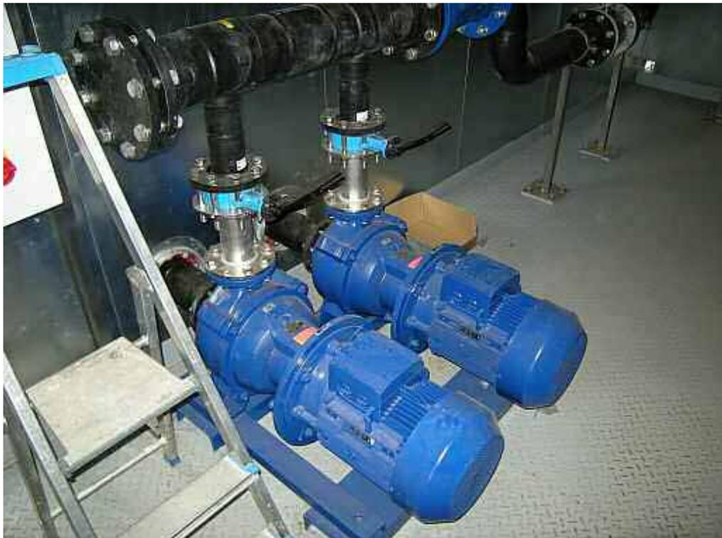
**Abbildung 5** Redundante Pumpe zur Beschickung der Bewässerungsmodule
