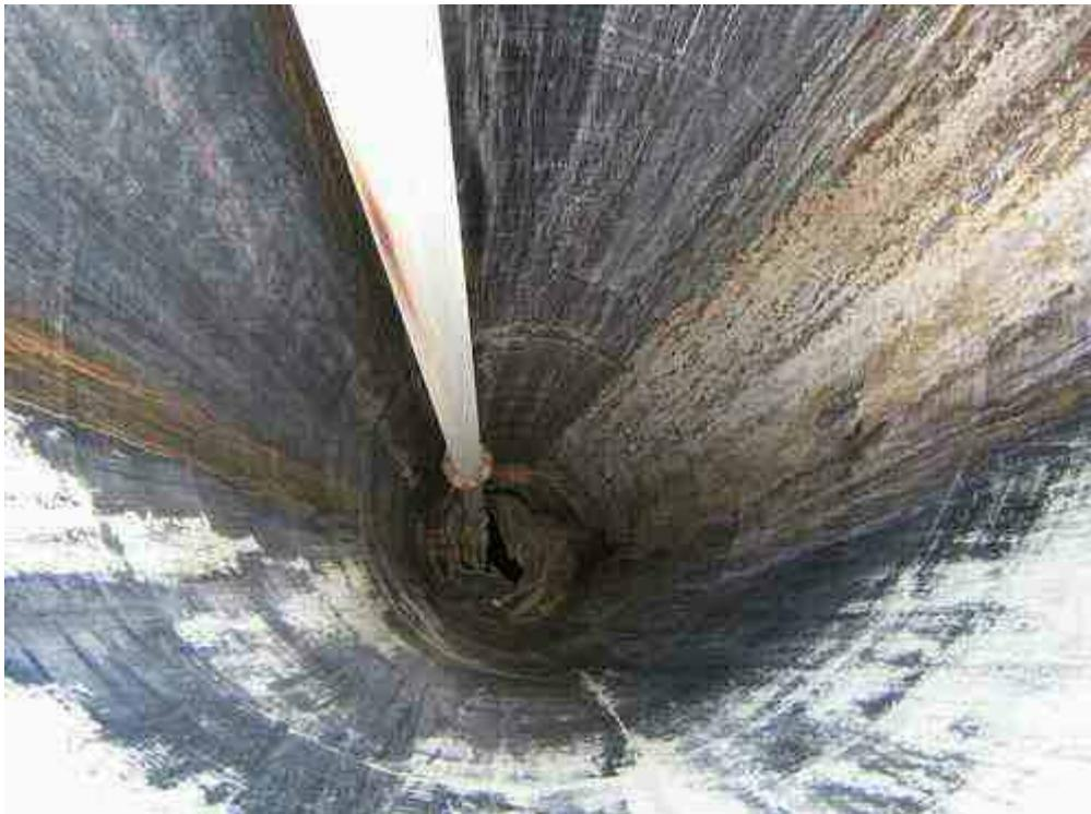
Abbildung 8: Erste Einbruchstelle in zwölf Metern Tiefe
