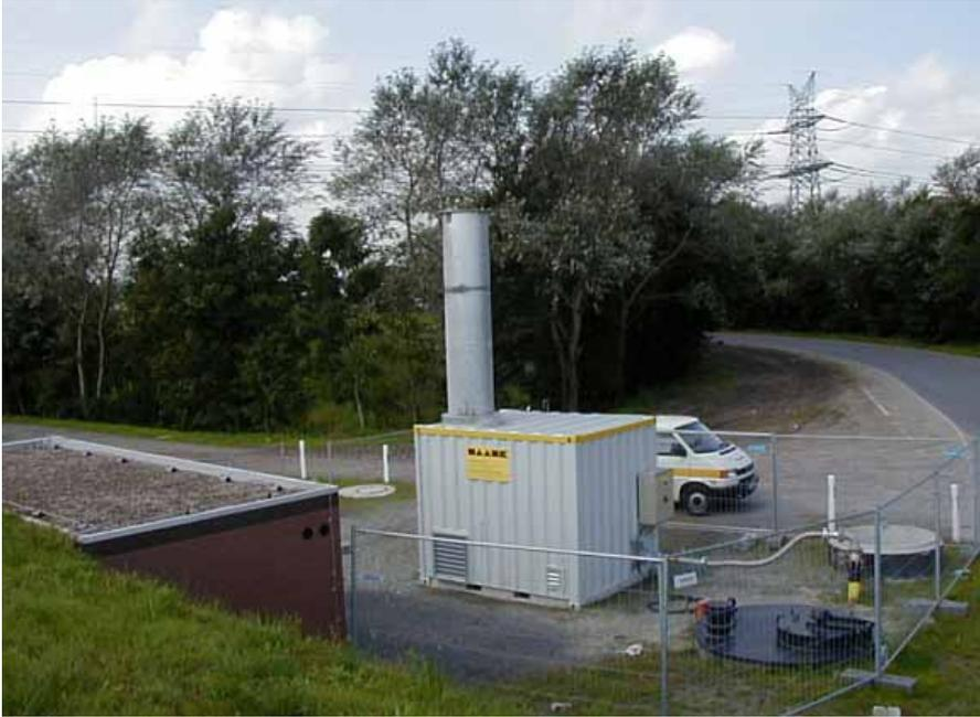
Abbildung 4: Deponiegasverdichter- und Fackelanlage (750 kW<sub>th</sub>)
