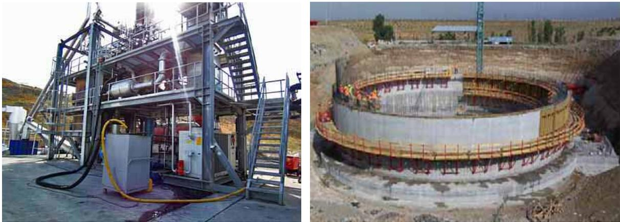
**Bild 6** Pyrolyseanlage sowie in Bau befindlicher Fermenter auf einer Großdeponie
