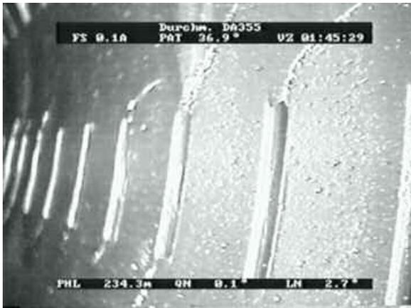
**Abbildung 3:** Rissbildung in Drainagerohrschlitzungen
