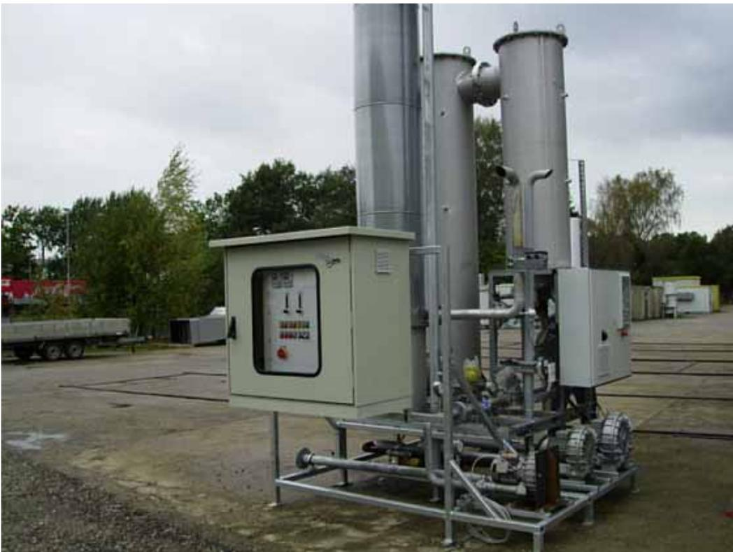
Abbildung 8: HAASE-Schwachgasfackel im Werk Neumünster
