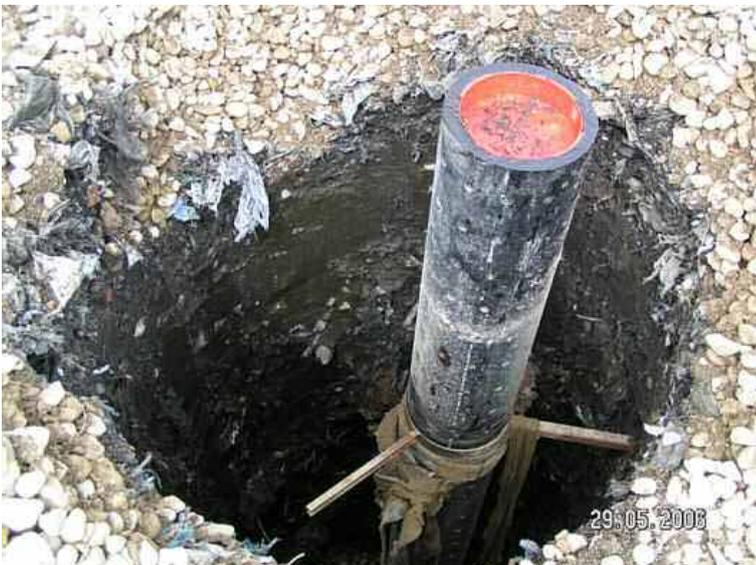
**Bild 2** Ausführungsbeispiel eines Vertikalbrunnens
