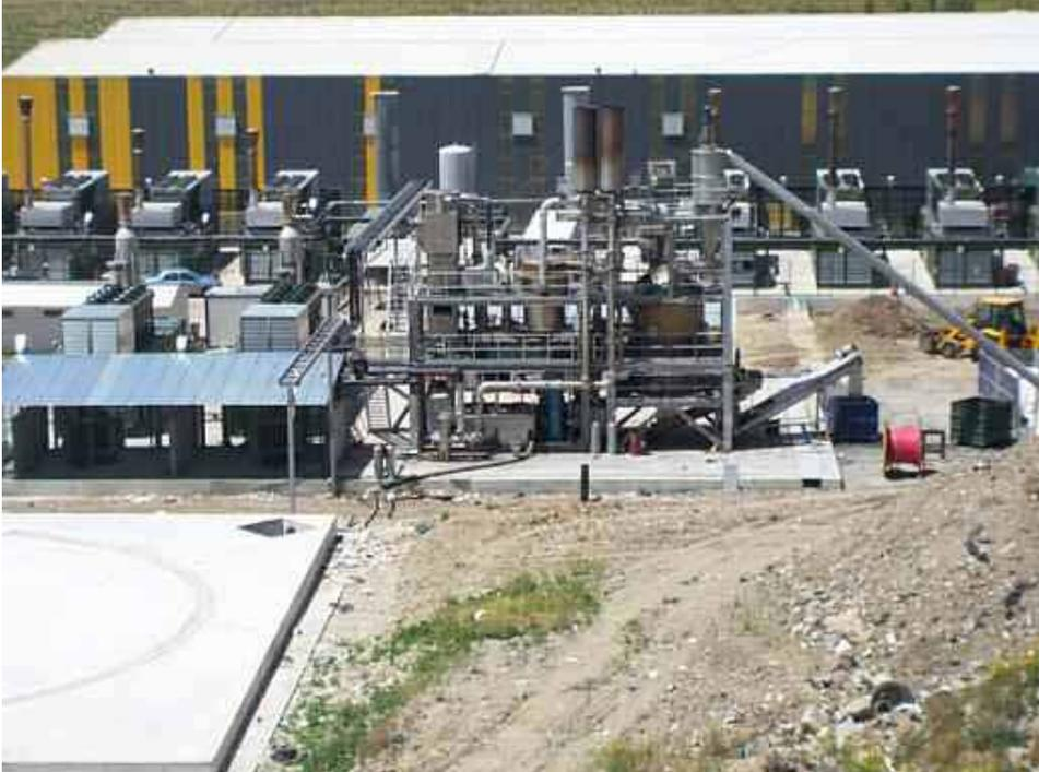
**Bild 5** Anlage für die Deponiegasverstromung auf einer Großdeponie
