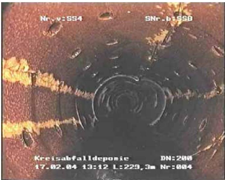
**Abbildung 9:** Querschnittsverengung im Stz-Rohr DN 200
