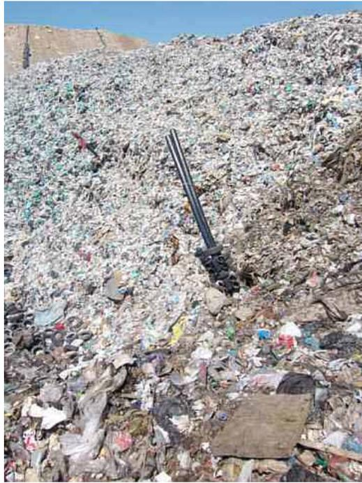
**Bild 4** Hangschüttung mit kontinuierlicher Müllverlagerung
