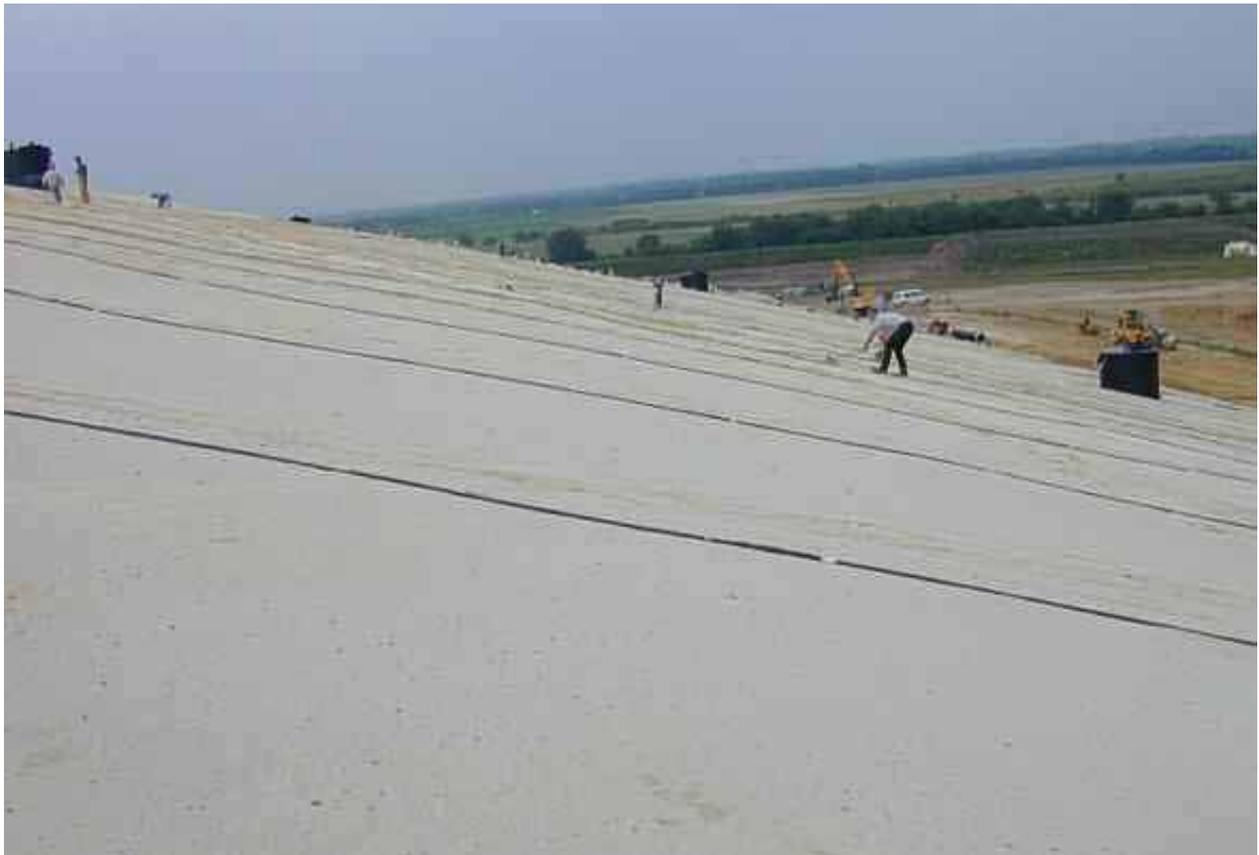
**Abbildung 4** Verlegung der Messelektroden unterhalb der Kunststoffdichtungsbahn
