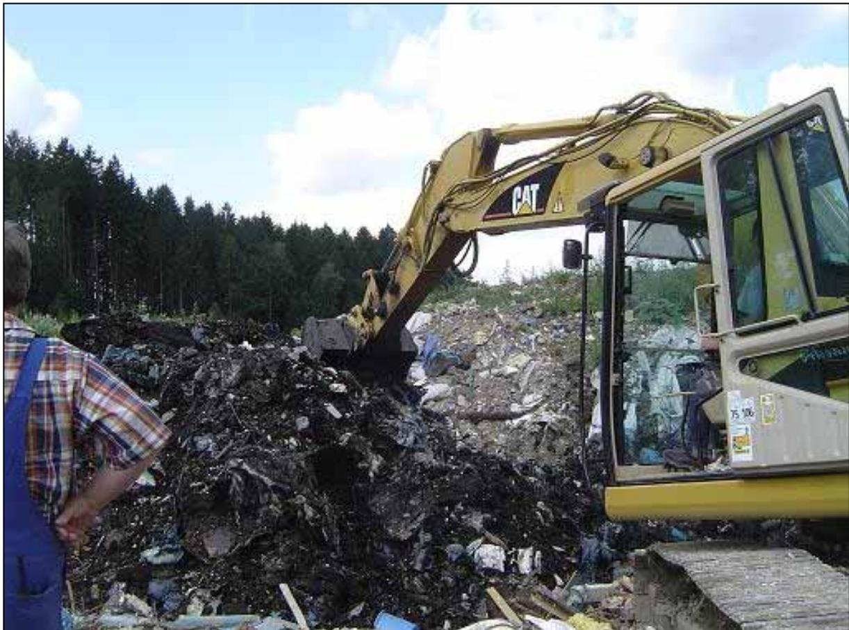
**Abbildung 1** Entnahme des Abfalls aus der Deponie
