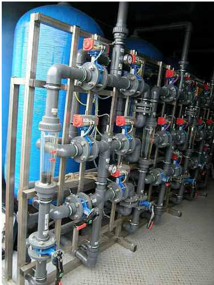
**Abbildung 3** Anlage zur Sickerwasserbehandlung
