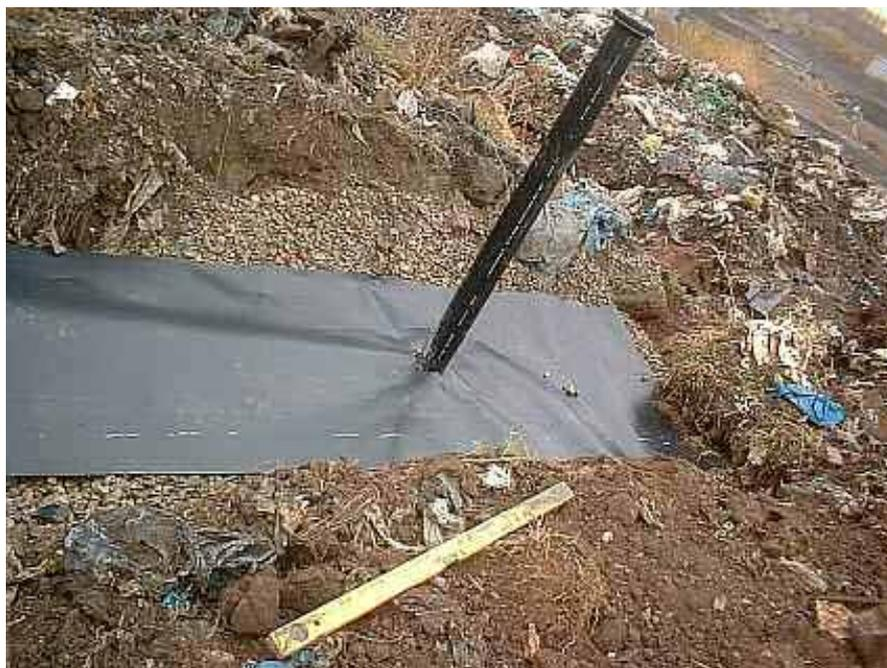
**Abbildung 8** Füllstandsanzeige am Ende einer Rigole
