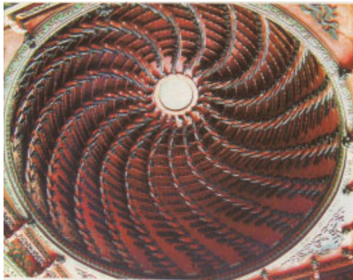
Abbildung 8: Dach der Gildehaus-Bühne (Kunqu-Museum Suzhou) (Wu Xinlei : 378)
